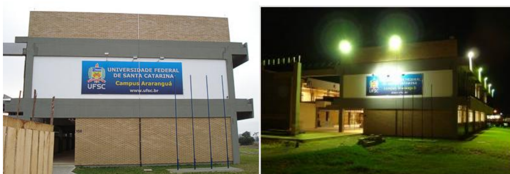
Figura 4. Prédio das Instalações da UFSC – Campus Araranguá.
